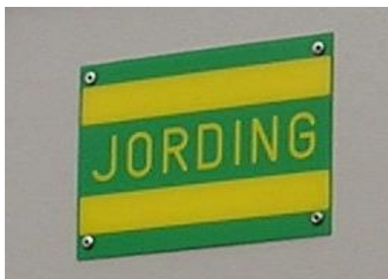
Figur 1: Eksempel på skilt for jordslutter / Figure 1: Example of sign for earthing switch
